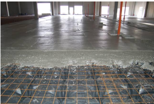
Fig. 3 First pour phase executed
