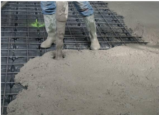
Fig. 3 Pour in progress
