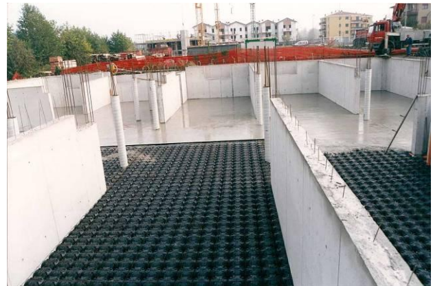
Fig. 2 Partially executed pour
