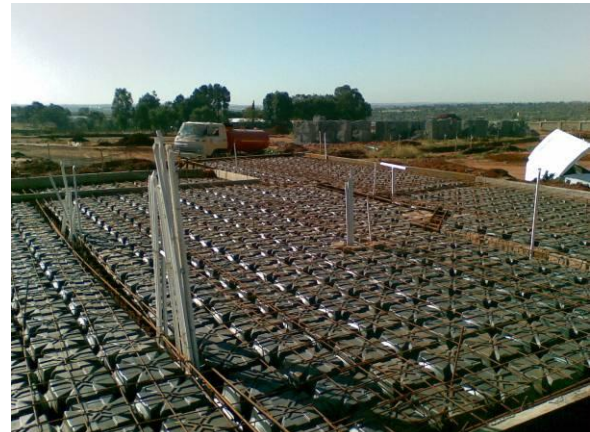
Fig. 2 Modulo installed and ready to pour
