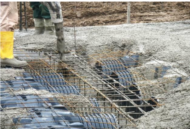
Fig. 3 Pour of the ground beam
